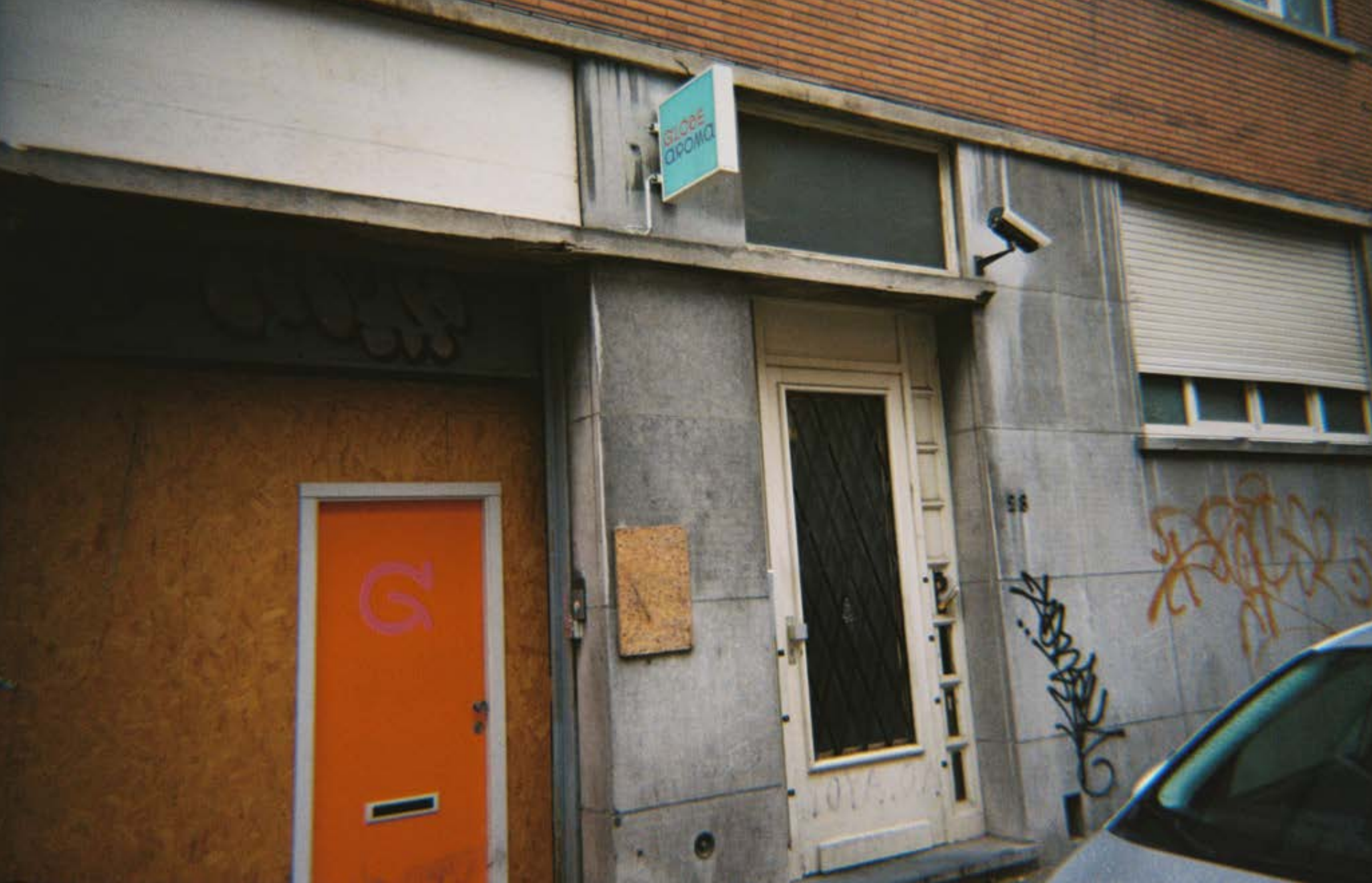
Gevel Broedplek Globe Aroma (Foto: Google Maps)
