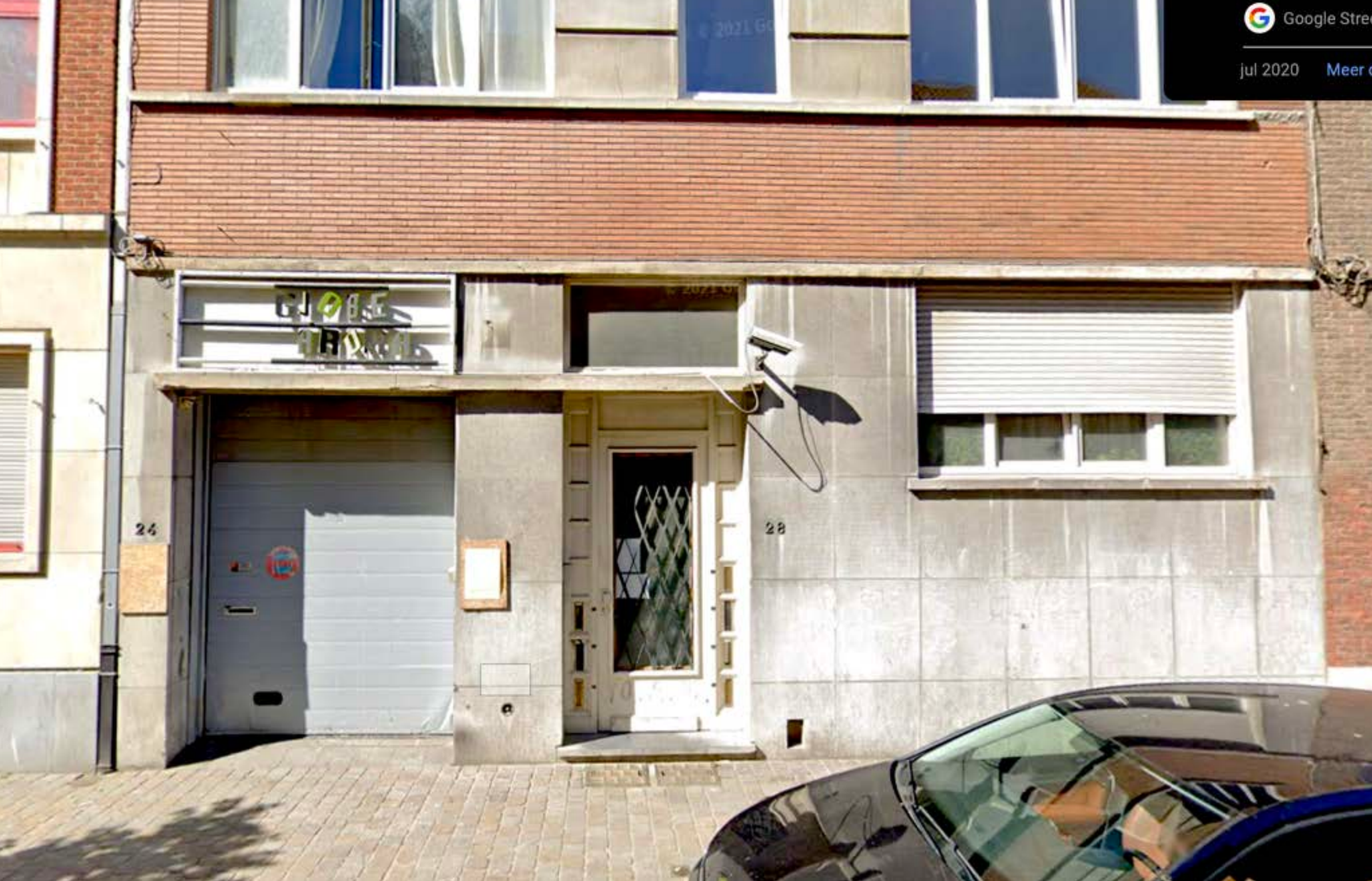
Gevel Broedplek Globe Aroma (Foto: Google Maps)
